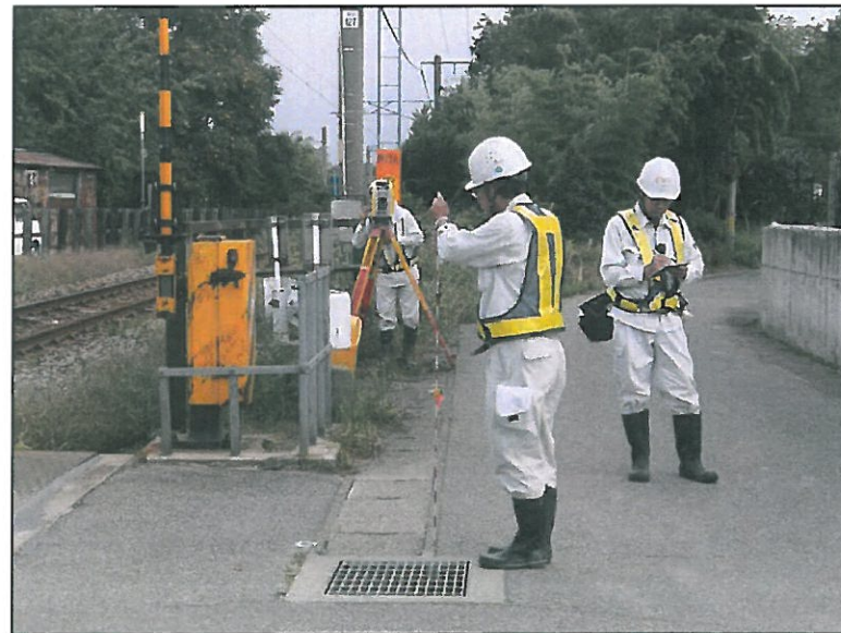
(参考)測量作業状況
