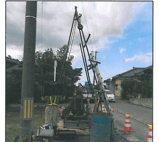
(参考)地質調査作業状況
