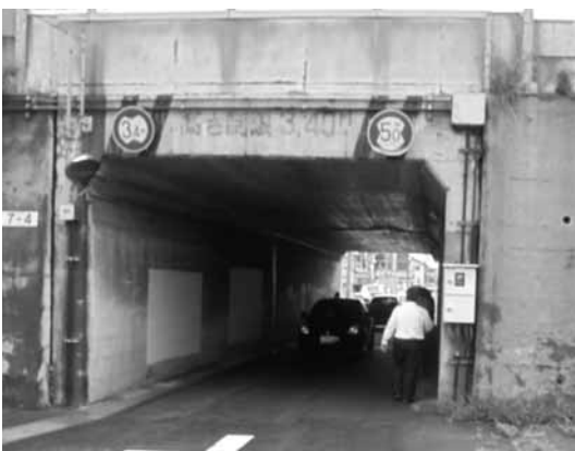
徒歩でボックスカルバートを通り危険性を確認しました
