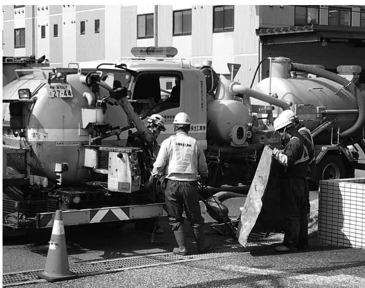
側溝清掃(バキュームカーによる)
