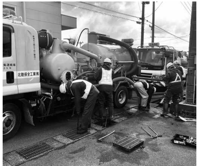
東区建設課による側溝清掃
