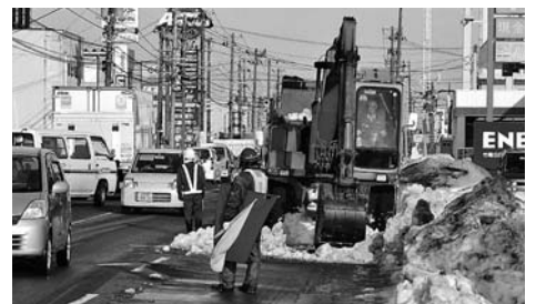
市道を2車線に復旧(協力:新潟市東区建設課)
