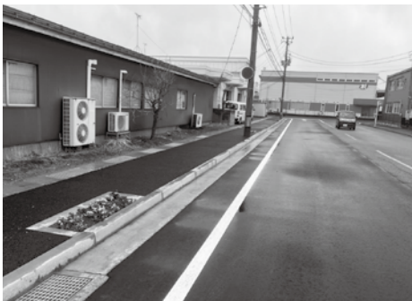
新設された植栽柵
