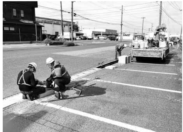
部会第5班の側溝蓋の架け替え(協力:東区建設課)
