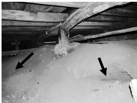
図1 五箇山の羽馬家住宅（国重文）で実際に「培養法」による硝石作りを行っていた床下、2か所の培養穴の跡（矢印）がみえる（2019年9月大瀬氏撮影）。
